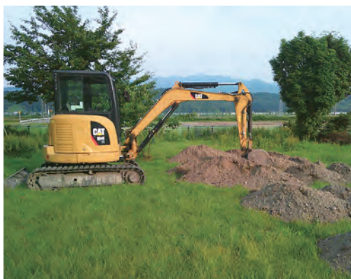
重機を入れての作業
